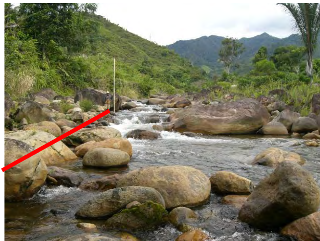
Tracé du canal d'amenée
